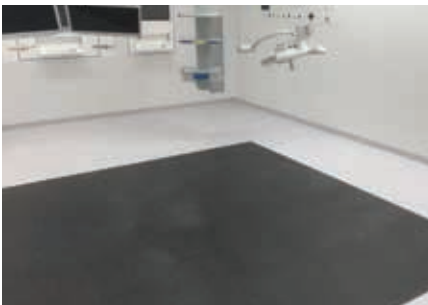
Bloc opératoire : zone centrale volontairement plus foncée, pour confort visuel des chirurgiens
